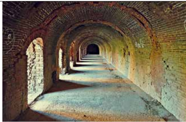
Κάμινος Hoffmann κεραμοποιίας Δηλαβέρη
